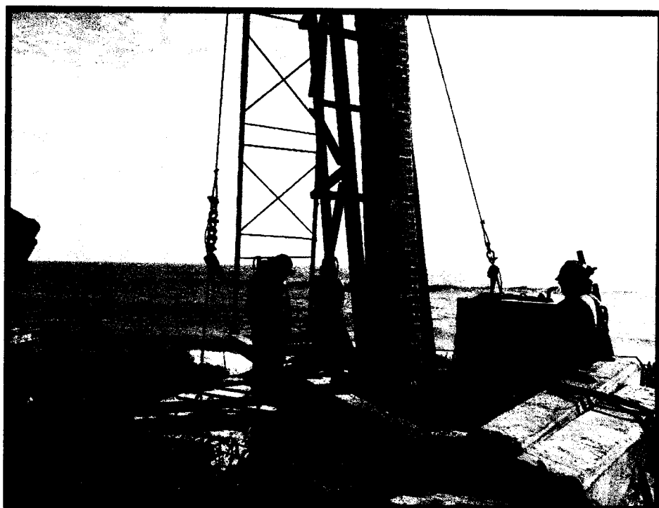
HINCADO DE PILOTE EN LOS EJES 132 - 136
